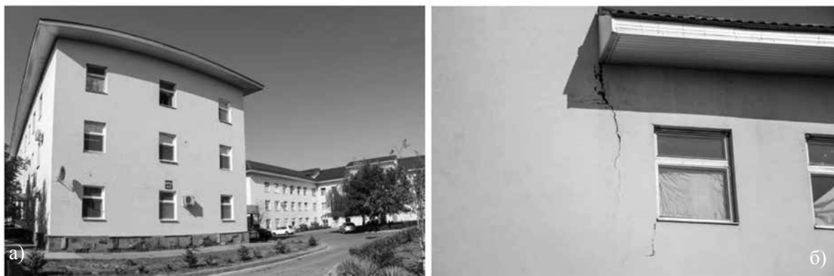
Рис. 5. Здание Буденновской центральной районной больницы: а) общий вид и б) трещины в стенах (фото В. В. Сербина, 2014 г.)
