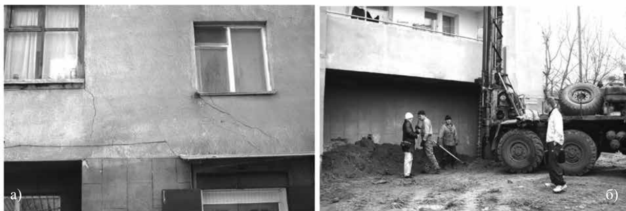
Рис. 6. Жилой дом по ул. Пушкина, 93 в г. Кисловодске: а) трещины в стенах, б) укрепление грунтовыми сваями (фото Б. Ф. Галая)
