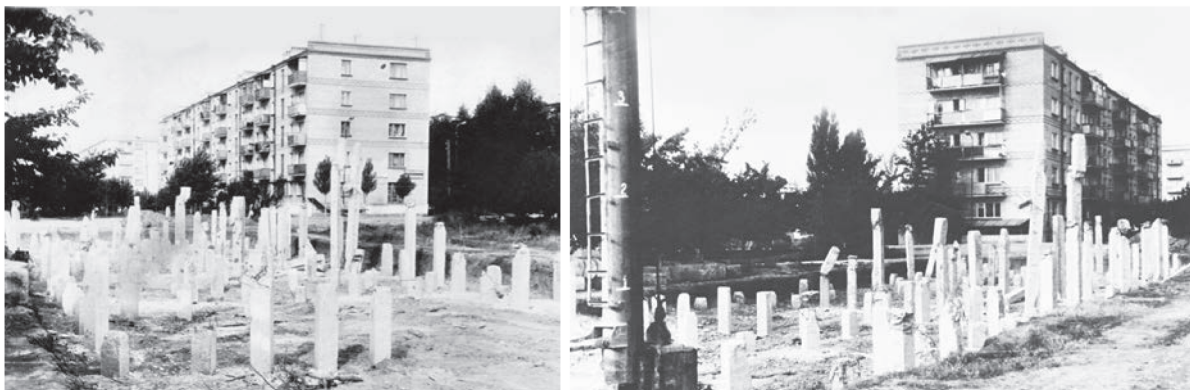
Рис. 7. Недобив свай на просадочных грунтах в г. Георгиевске
